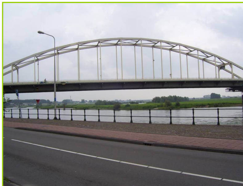
Foto 1 Wilhelminabrug: beeldbepalende infrastructuur.
