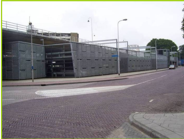
Foto 9 Tijdelijke parkeergarage onder de oostelijke helling van de Wilhelminabrug
